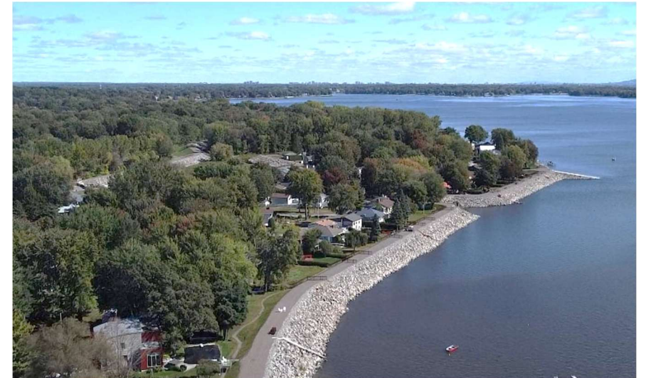
Digue à Sainte-Marthe-sur-le-Lac (Noovo, 2022)
